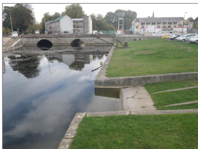
Vue du port – prise de vue depuis la Sèvre domaniale en aval
