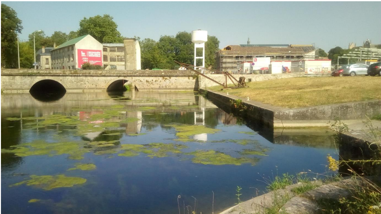
Vue de l'emprise du port concernée par le projet (quai de Belle Ile et cale de mise à l'eau situés à droite de la photo).
