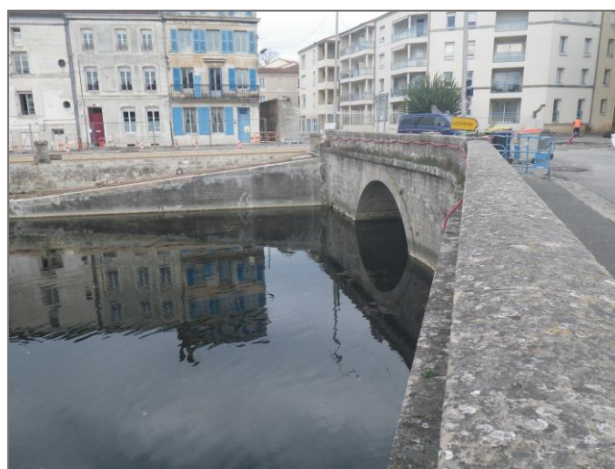
Vue amont du port et du chenal d'amenée (sortie souterraine).
